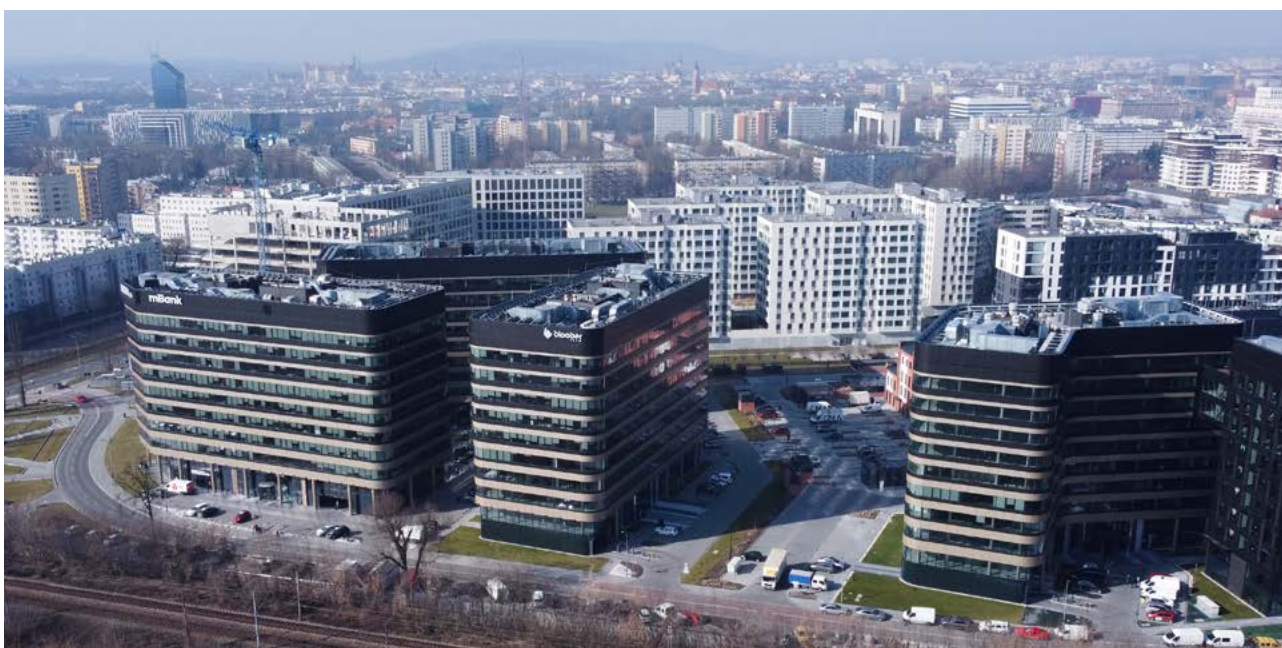
Fabryczna Office Park, Kraków
